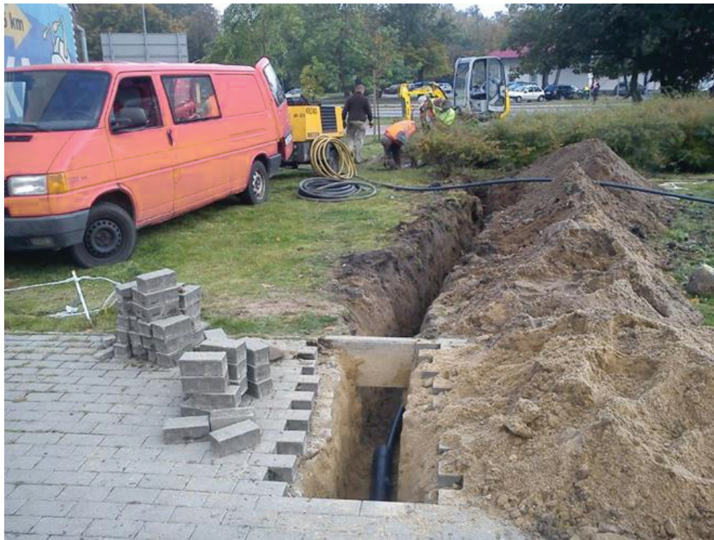
Fot. Budowa światłowodu. Autor: Michał Matuszewski.
