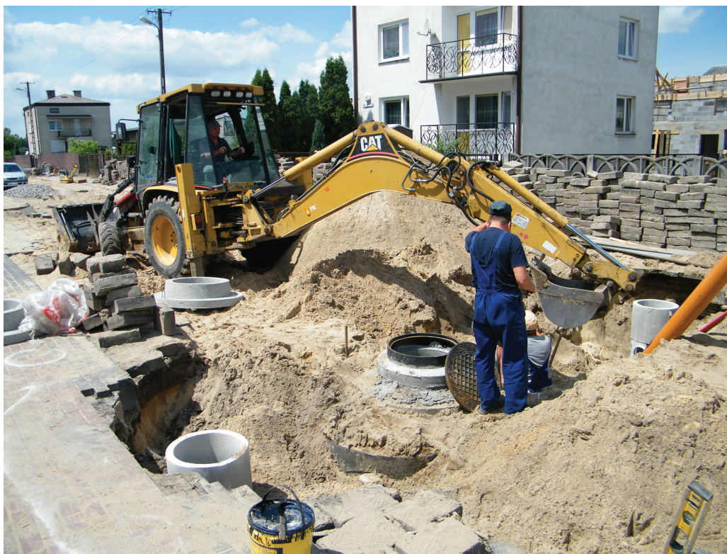
Fot. Budowa kanalizacji sanitarnej. Autor: Grzegorz Czwordon.
